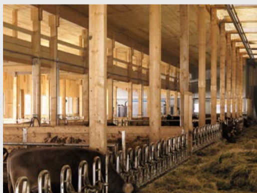
Oberhalb der Liegezone führt ein 60 Meter langer Besuchersteg; rechts Futtertisch, daran anschließend die Heu-Bergeräume.
