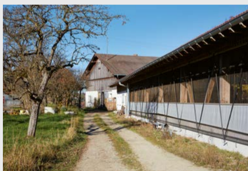
Der alte Obstgarten auf dem Weg der Erneuerung, die Umfahrt für den Milchlaster, der offene Stall.
