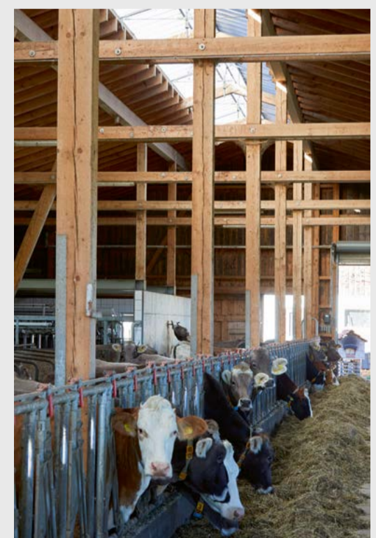
Richtig in Position gebracht sind eng stehende Stützen und Zangen in preiswertem Vollholz keineswegs störend, sondern geben räumlichen Maßstab.
