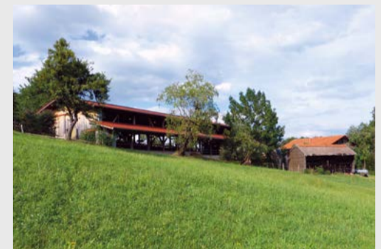
Durch höhenversetzt angeordneten Futtertisch, Fressgang und Liegeplatz ist es gelungen, den Stall in das zweiseitig geneigte Gelände zu integrieren. Rechts das separate Melkhaus.
