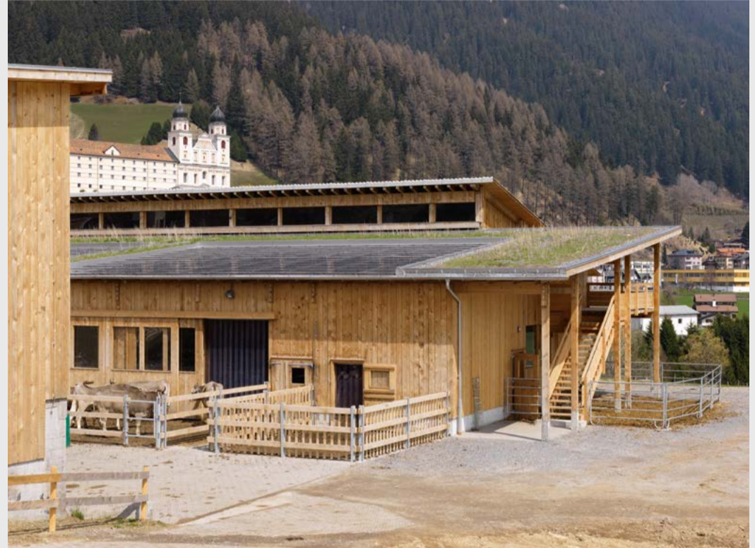
Lehrstall: Zwei flache, höhenversetzte Pultdächer, in der Mitte zweigeschossig, mit Austritt des Besuchergangs; im Hintergrund das Kloster Disentis. Beachtenswert die Integration der Solarpaneele.
